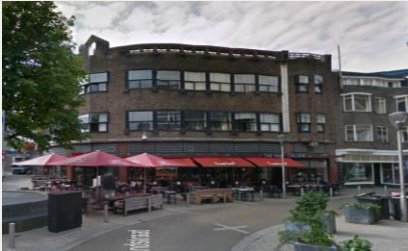
KAPELHOF 31 / HEUVELSTRAAT 126, TILBURG
