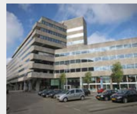
Project Bokelweg – Rotterdam
